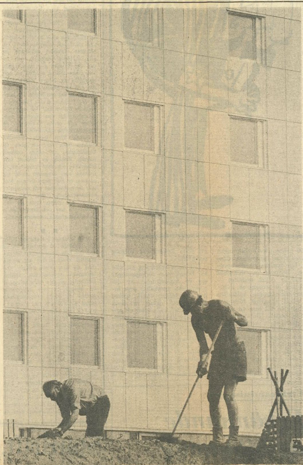
Västra Flemingsberg. Stor-Stockholms nyaste flerfamiljsområde. Totalt skall 2 300 lägenheter byggas. Av 150 inflyttningsklara lägenheter står i dag 96 tomma.
